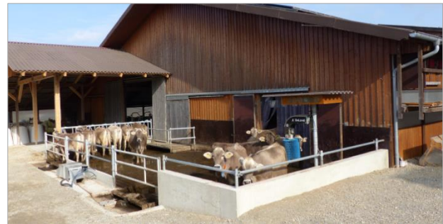
Bild 7: Stirnseitig angeordneter, gut frequentierter Multifunktionshof mit Fressplätzen, Putzbürste und Leckstein (im Vordergrund nicht sichtbar)
