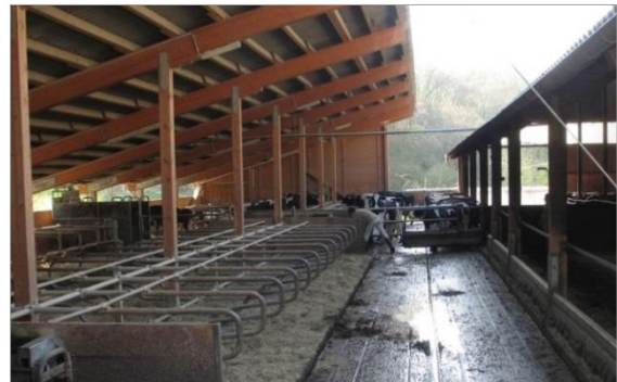
Bild 2: Integrierter Laufhof als Verbindungselement zwischen der Liegehalle (links) und dem Altgebäude (rechts, Nutzung des Futtertisches)
