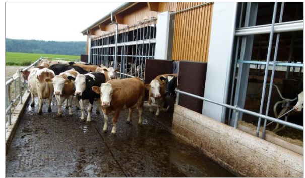
Bild 6: Ein außenliegender, rechteckiger Laufhof erlaubt die Kombination mit einem Warteraum zum Melken und einer stationären Entmistung
