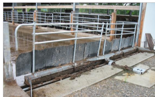
Bild 8: Schieberabwurföffnung außerhalb des Laufhofs, Gatter auf Schieber als Treibhilfe für Wartehof
